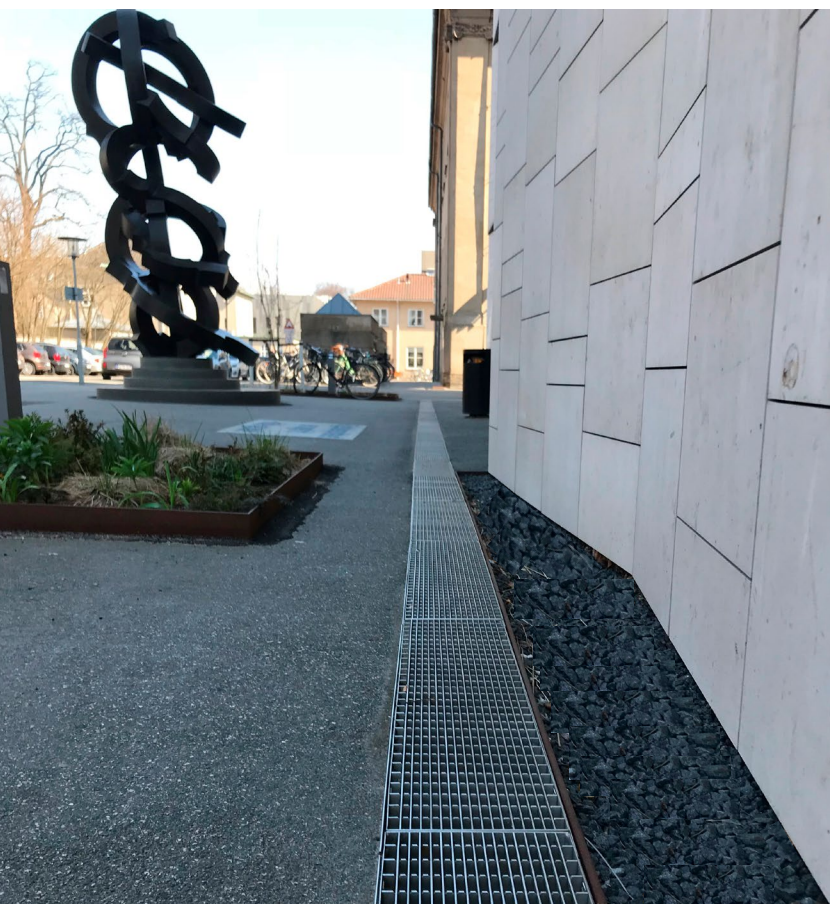
Projekt: Baldersbo kloakrenovering, København Anvendt: Filcoten Pro NB100 med støbejerns riste Rådgiver: Hartvig Consult
