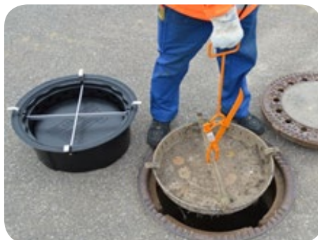
Fjern evt. eksisterende løv- og sandfang
