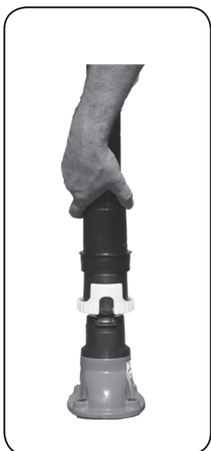
Pres herefter spindel-forlængeren ned på ventil-halsen.
